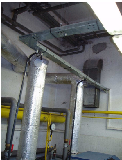
Stávající kouřovody kotlů
